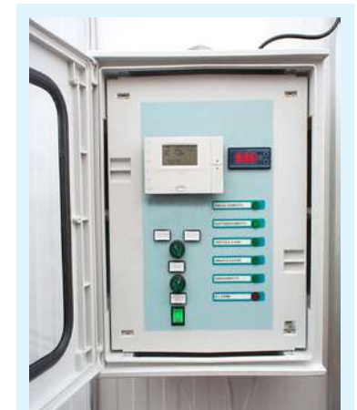
Panel de control remoto, para una gestión puntual de temperatura y humedad.
