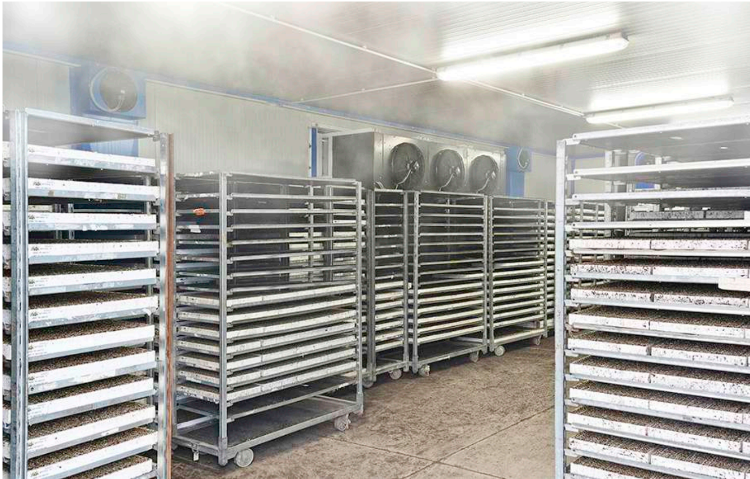
Cámara para la conservación de las semillas.
