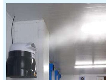
Humidificateur en fonctionnement à l'intérieur de la chambre.
