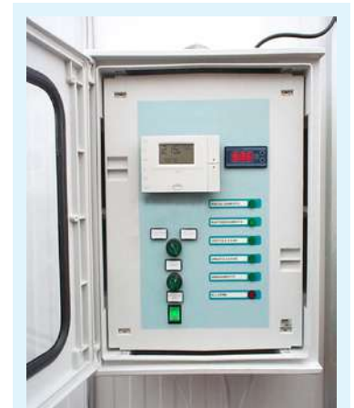
Panneau de commande à distance, pour une gestion rapide de la température et de l'humidité.
