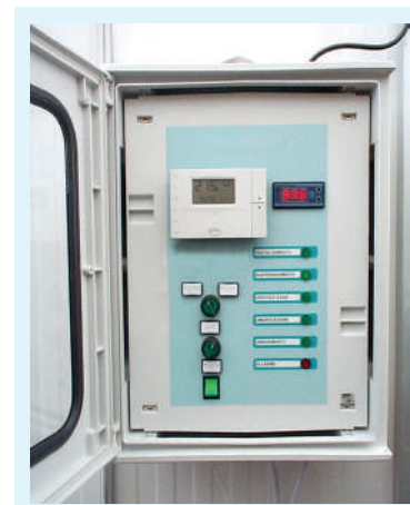
Pannello di controllo remoto, per una gestione puntuale di temperatura e umidità.
