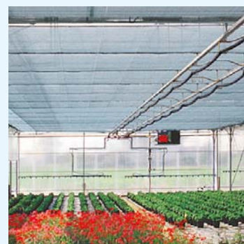
Irrigatore in serra con schermo termico . Traversa superiore sagomata ad omega per la presenza di un generatore.
