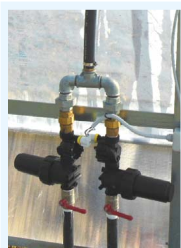
Doppio gruppo alimentazione: valvola a sfera, filtro a rete ed elettrovalvola.
