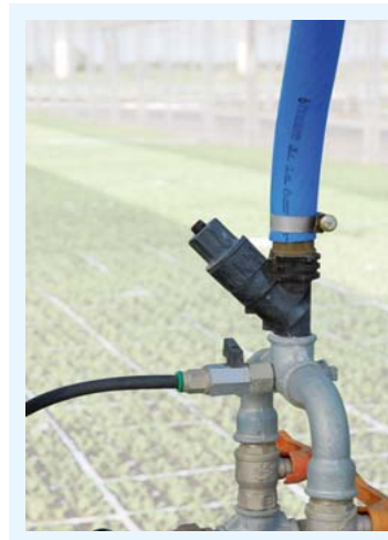
Gruppo ripartizione acqua con valvole per ugelli laterali e regolatore di pressione.
