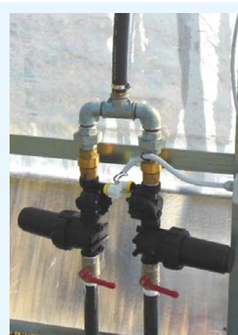
Doppio gruppo alimentazione: valvola a sfera, filtro a rete ed elettrovalvola.
