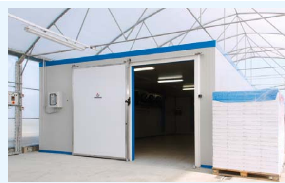
Cella di germinazione all'interno di una avanserra.
