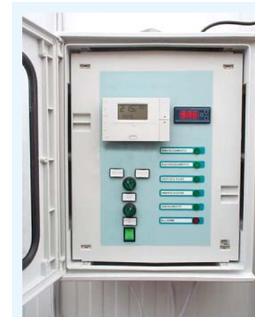
Contrôle de la température et de l'humidité dans toute les parties de la chambre pour une germination homogène.
